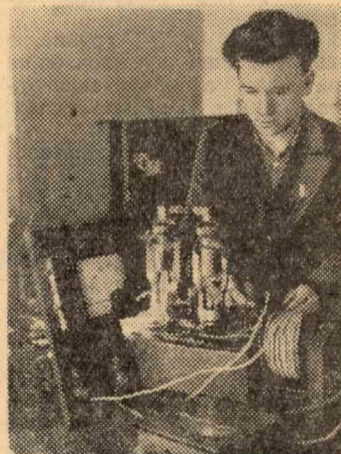
На снимке: студент группы 611-1 М. Кобытев за проверкой работы схемы управления с тиратронами. Фото Я. Абутова.
