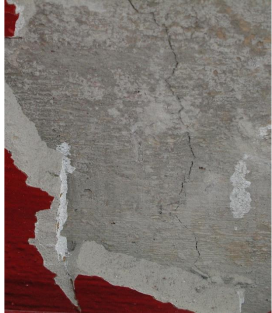
Рис. 5.19. Схема расположения акселерометров (1...13) на фундаментах 1–7 при проведении испытаний (а) и фотография трещины в теле аварийного фундамента 2 на боковой поверхности в точке измерения «2» с амплитудой горизонтальных колебаний A_{0i} = 0,1097 мм (б)
