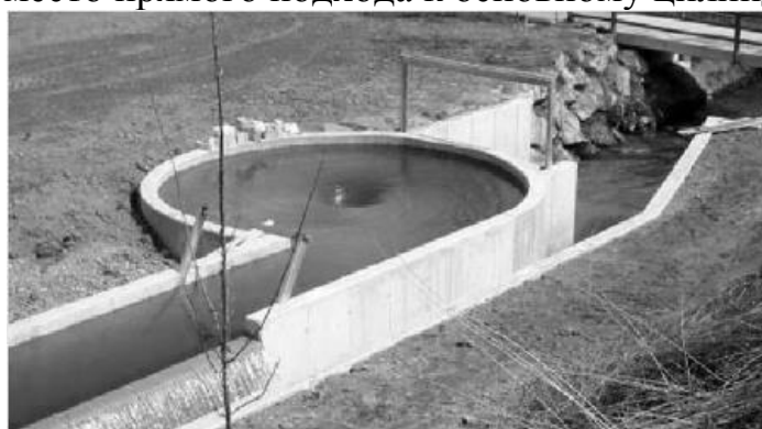
Рис. 1. Фотография действующей МикроГЭС (г. Оберграфендорф)
