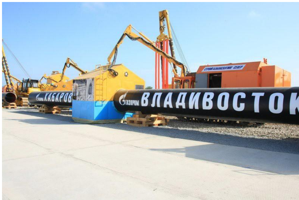
Рисунок 1.1– Сварка первого стыка ГТС «Сахалин-Хабаровск-Владивосток»
