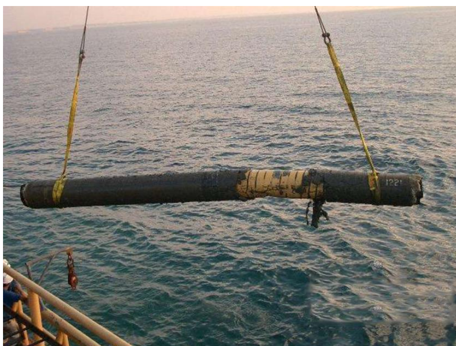
Рисунок 2 – поврежденная секция, демонстрирующая вмятины на трубопроводе. [14]
