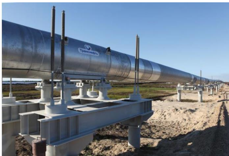
Рисунок 16. – Неподвижные опоры
