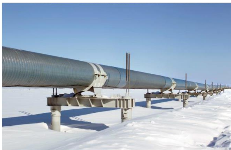
Рисунок 17. – Продольно-подвижная и свободно-подвижная опора
