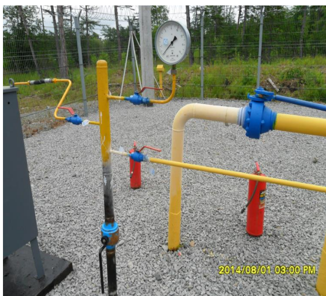
Рисунок 2.1 – Внешний вид стояка отбора импульсного газа
