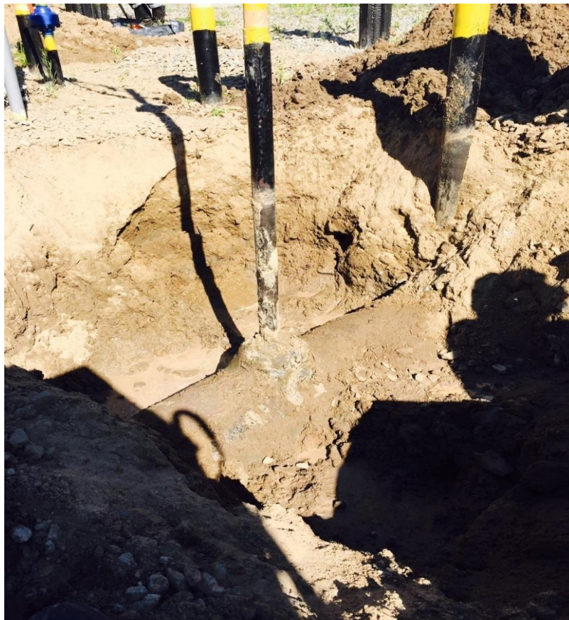
Рисунок 2.2 – Внешний вид стояка отбора импульсного газа
