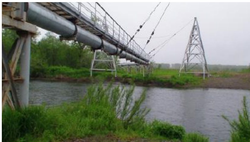
Риснок 20. Строительства НДС трубопровода для переходов через реку
