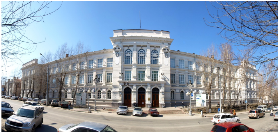
Рис.3.9 Фото фасада главного корпуса ТПУ
