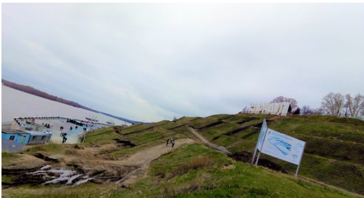
Рисунок 1.2 – Террасирование Обского склона (фото Андреевой А.Э)
