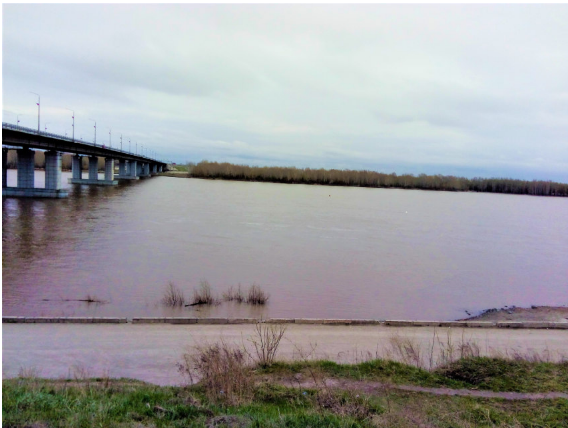
Рисунок 1.3 – Новый мост через реку Обь (фото Андреевой А.Э)
