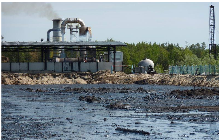
Рисунок 23 – Полигон для переработки нефтешламов
