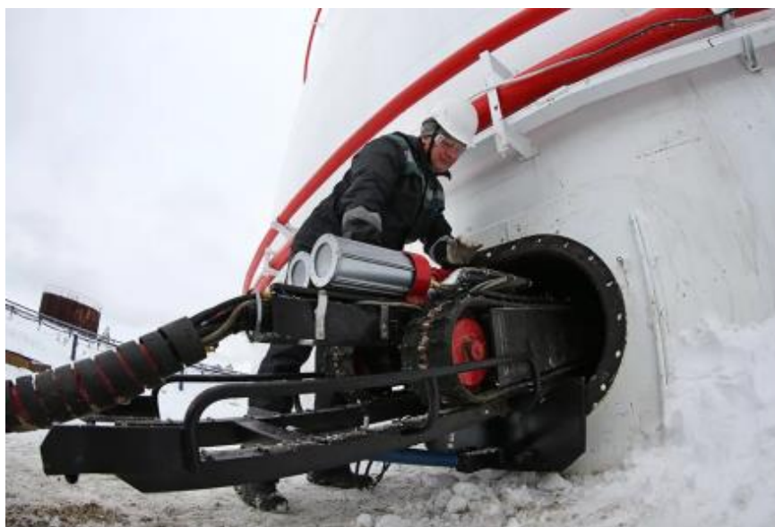
Рисунок 16 – Механический метод зачистки резервуара
