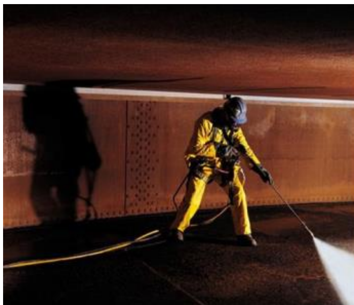
Рисунок 15 – Ручной способ очистки резервуара
