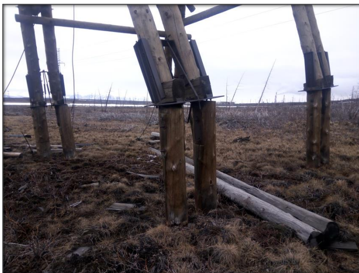
Рисунок 2.5.1. Деформированная опора
