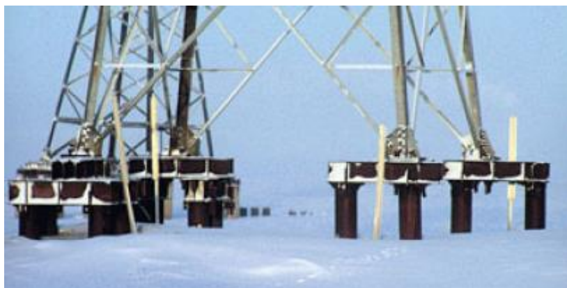
Рисунок 3.1.2. Установки сезонно-охлаждающего устройства [76]
