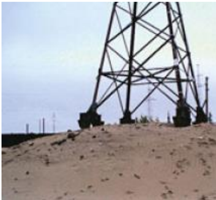
Рисунок 3.1.1. Обваловка фундамента опор [76]
