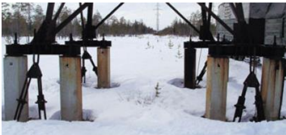
Рисунок 3.1.3. Усиление фундаментов крестовыми сваями [76]
