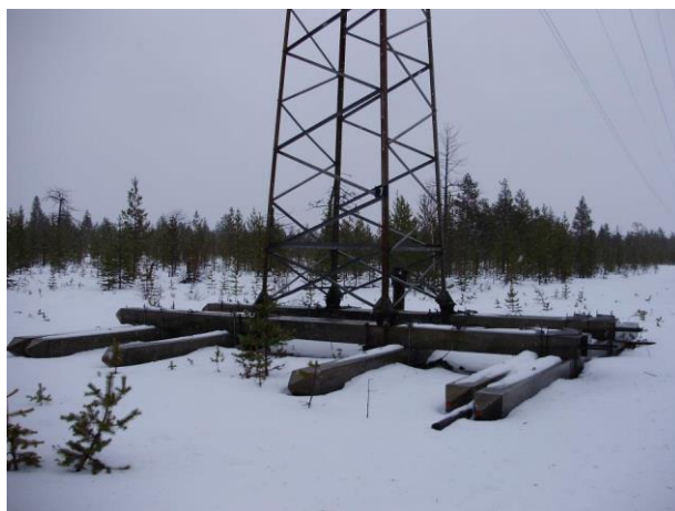
Рисунок 3.1.4. Сооружение поверхностных (лежневых) фундаментов [76]
