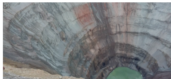
Рис. 2. Водопроявления на бортах кимберлитового карьера «Мир»
