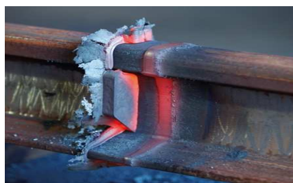
Рис. 4. Внешний вид сварного соединения
