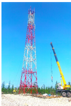
Рис. 1 Антенно-мачтовое сооружение связи
