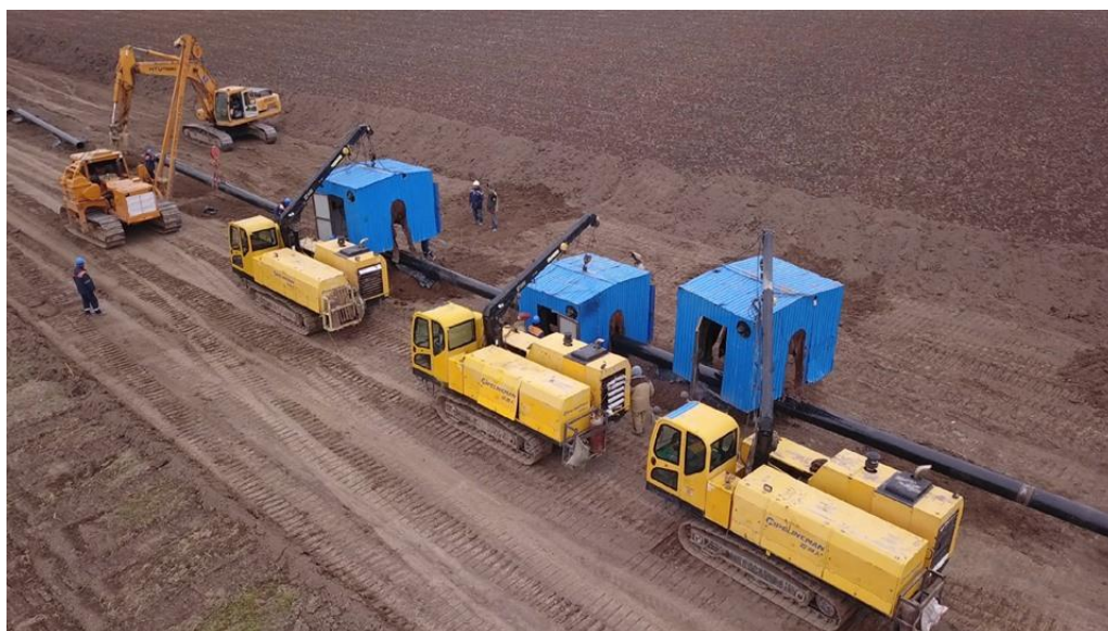
Рис. 1. Строительство магистрального газопровода на севере Кыргызстана .
