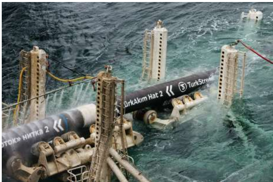
Рисунок 23- Процесс погружения трубопровода
