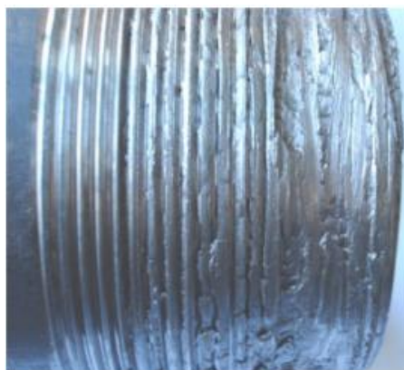
Рисунок 3 – Разрушение резьбы в результате неправильного скручивая труб
