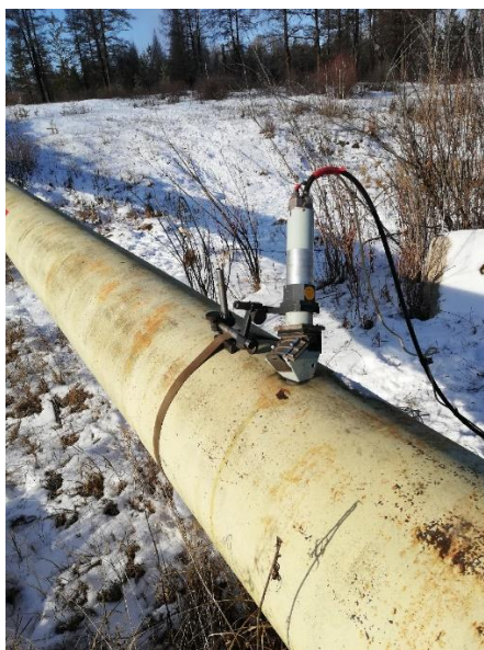
Рис. 4.3 – Процесс измерения напряжений на объекте
