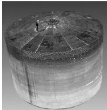
Рисунок 2 – Общий вид облака точек внутренней поверхности резервуара [1]
