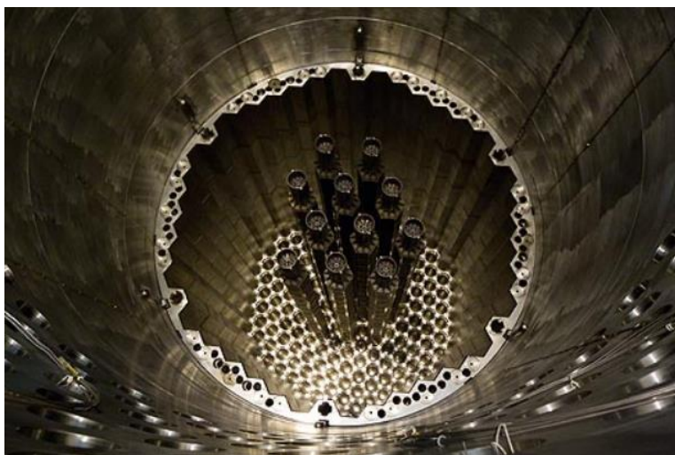
Рисунок 8 – Вид на реактор изнутри до полной загрузки
