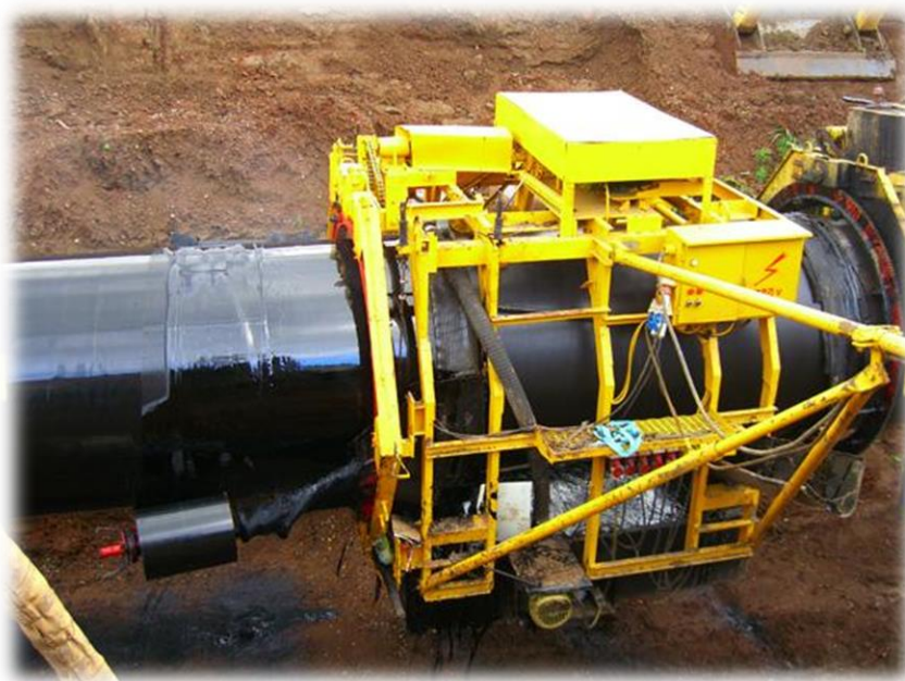
Рис. 2.24 Нанесение нового изоляционного покрытия
