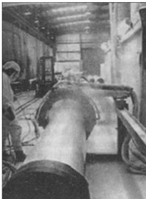
Рис. 4.4 Нанесение жидкого двухкомпонентного покрытия в заводских условиях
