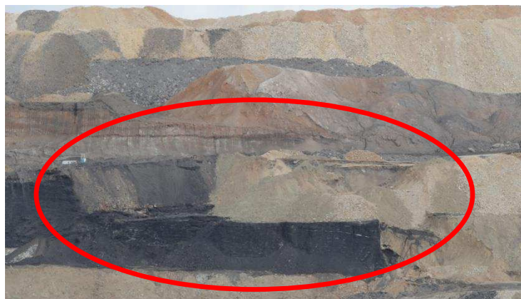
Рис.1 Район деформаций карьерных откосов (гор +450м.- +425м)
