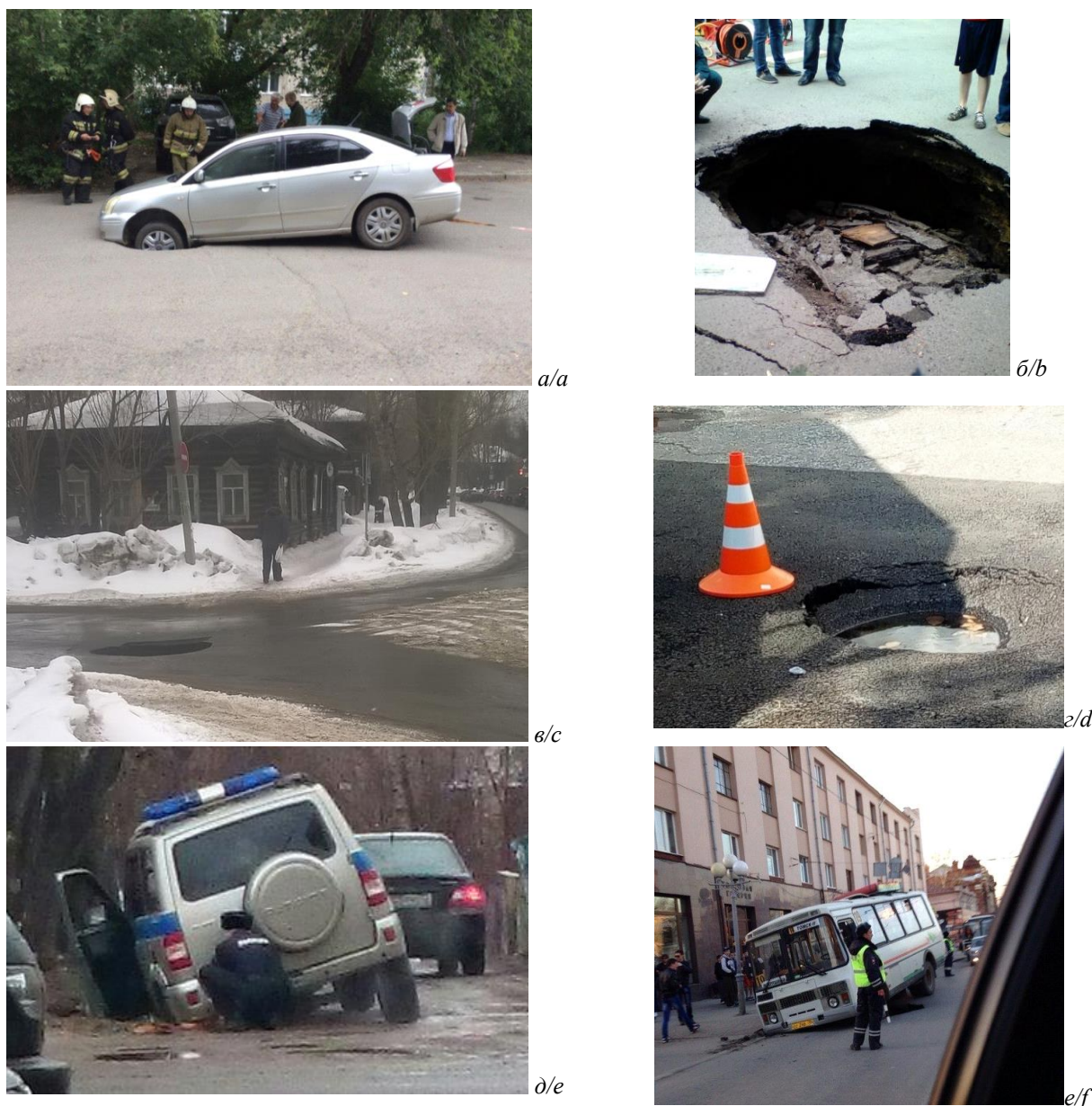
Рис. 1. Суффозионные провалы: а, б) ул. Карпова, 2017; в) ул. Алтайская, 2018; г) ул. Пирогова, 2020; д) ул. Лебедева, 2015; е) пр. Ленина, 2014
