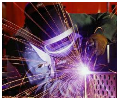
Рисунок 46 – Сварка металлических конструкций
