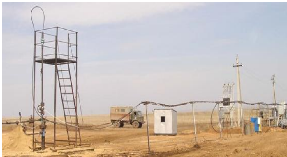
Рисунок 23–Расстановка наземного оборудования установки прогрева скважин
