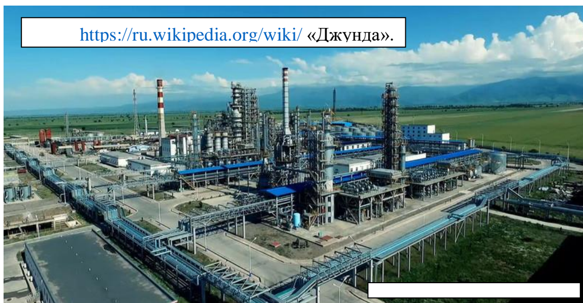
Рисунок 5 - Нефтеперерабатывающий завод «Джунда»
