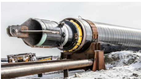
Протаскивание трубы в футляр на берме траншеи
