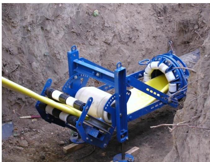
**Рис.5.19** Втягивание полимерного рукава
