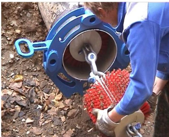
**Рис.5.10** Очистка полости существующего дюкера
