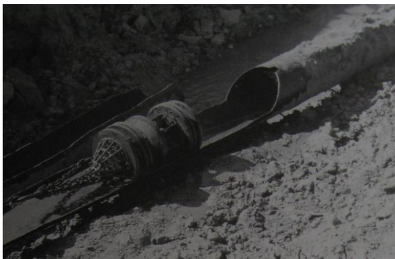
**Рис.2.3** Вывод очистного поршня из трубопровода
