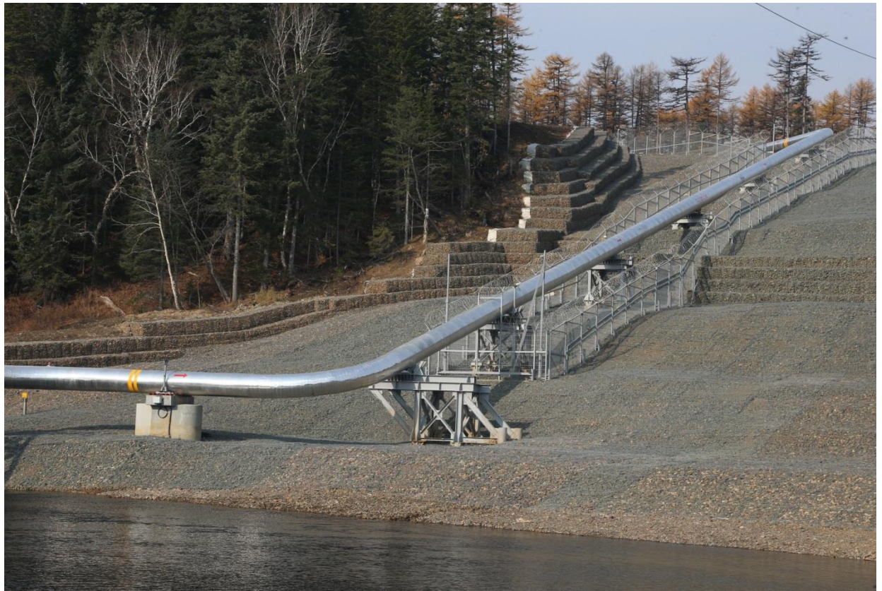
Рис. 2 – Отводы при надземной прокладке трубопроводов
