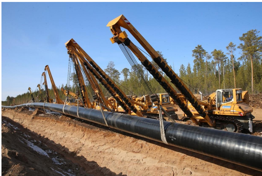
Рис. 7 – Укладка трубопровода в траншею
