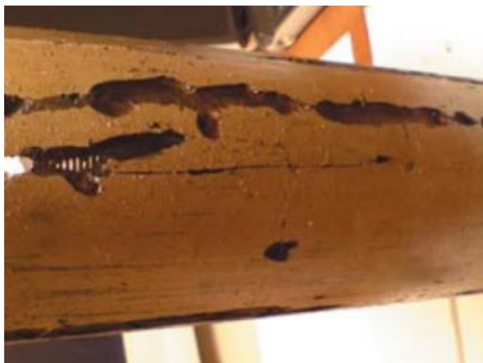
Рисунок 18 – Мейза-коррозия корпуса ПЭД ( Барсуковское м/р)
