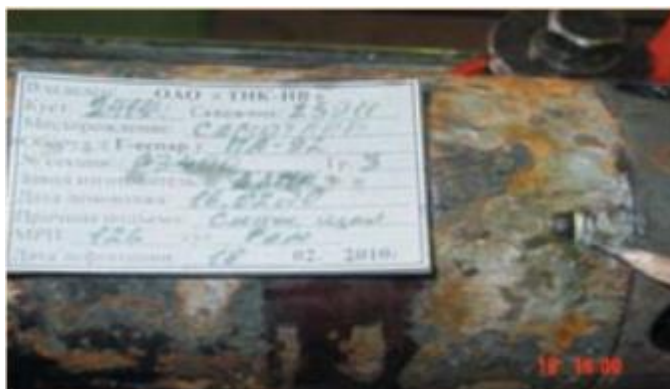
Рисунок 19 – Коррозия корпусов ПЭД и ГЗ
