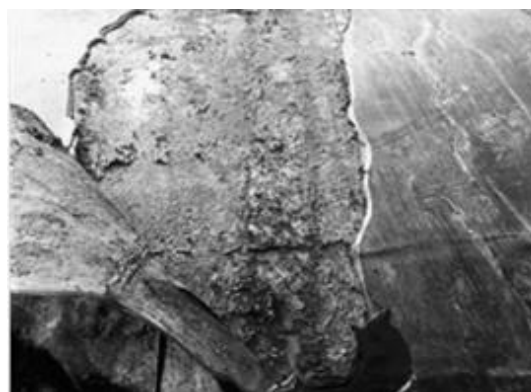
Рисунок 14 – пример подповерхностной коррозии
