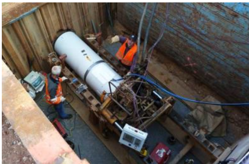
Рисунок 5. Внешний вид процесса микротоннелирования
