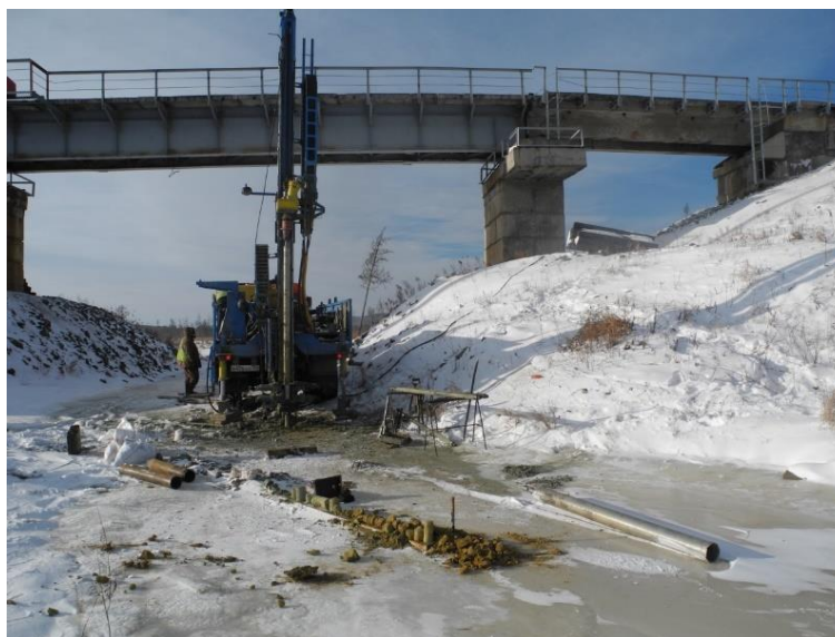
Рисунок 3 – Бурение скважины
