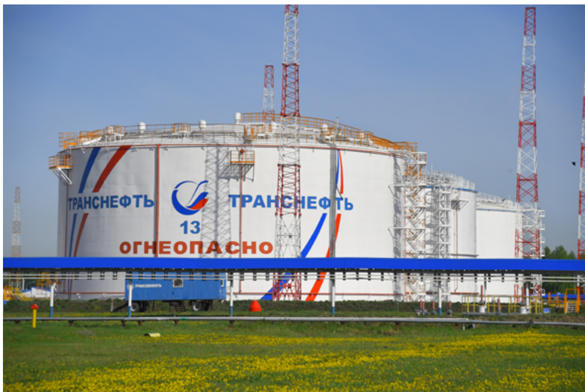
Рисунок 2.3 – Резервуарный парк АО «Транснефть - Западная Сибирь»
