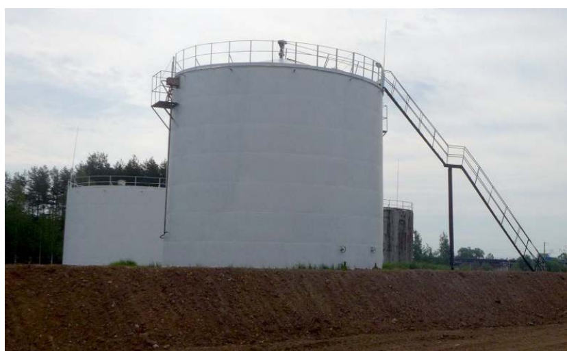
Рисунок 1.2 – Емкость для хранения нефтепродуктов после нанесения огнезащитного покрытия [11]
