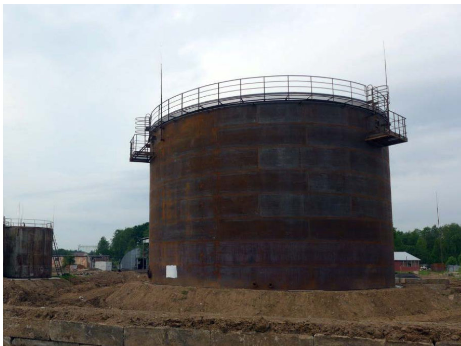
Рисунок 1.1 – Емкость для хранения нефтепродуктов до нанесения огнезащитного покрытия
