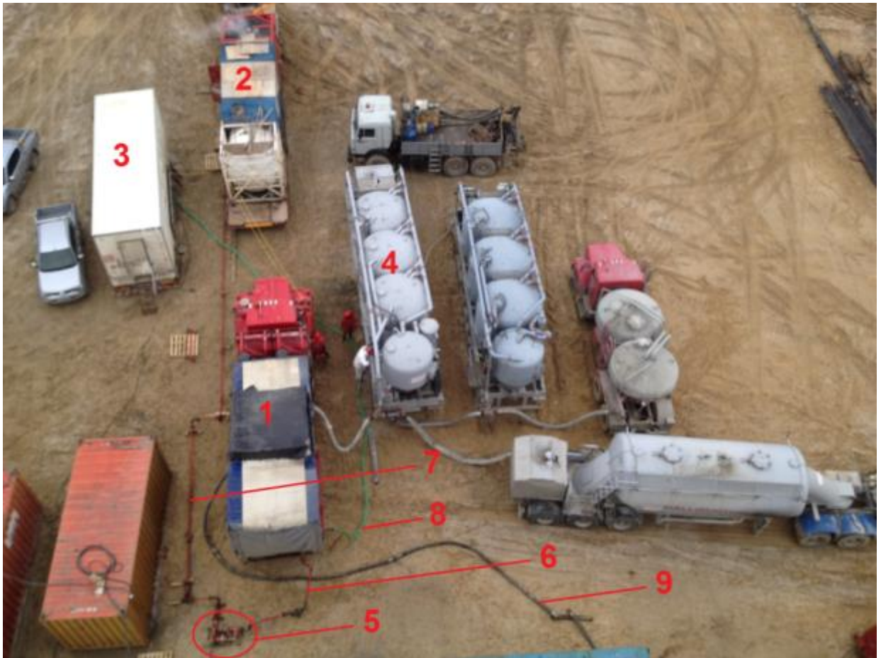
Рисунок 53 – Расстановка техники для цементирования, состав:
