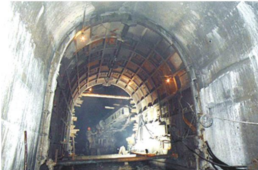
Рисунок 1.1 – Туннель на ГЭС-1
