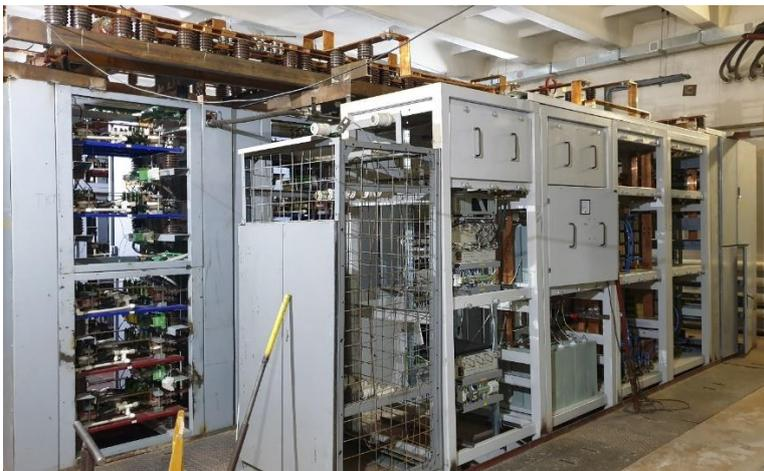
Рисунок 2.8 – Фото штатного ключа-прерывателя ИП обмотки CS
