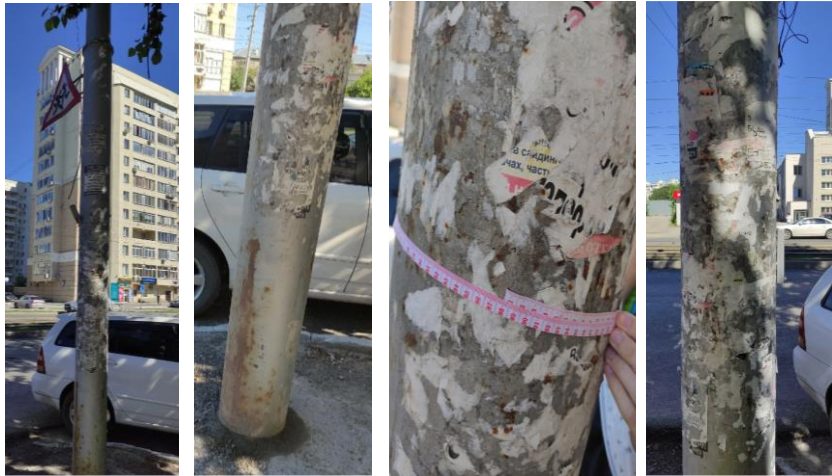
Рисунок 1 – Этапы проведения обследования опоры контактной сети
