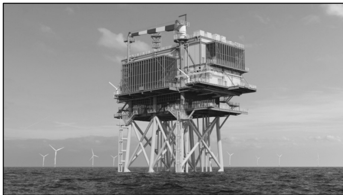
Рисунок 1.14 – Платформа морской трансформаторной подстанции
