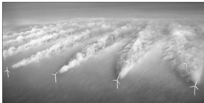
Рисунок 1.16 – Визуально наблюдаемый шлейф турбулентного потока вызываемого аэродинамическим следом за ветроэнергетическими установками (ВЭС «Horns Rev 1»)
