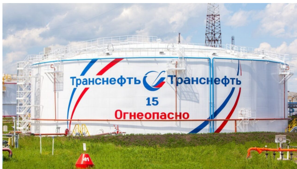
Рисунок №1 Резервуар вертикальный стальной 20000 м3
