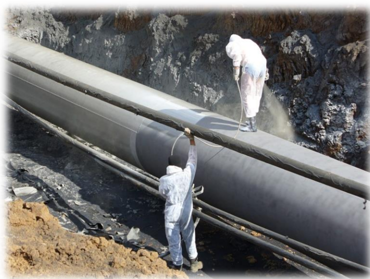
Рисунок 16 – Участок очищенной трубы
