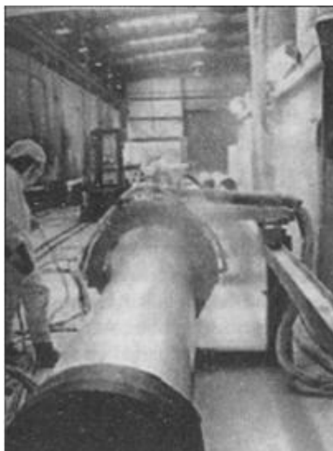
Рисунок 23 – Нанесение жидкого двухкомпонентного покрытия в заводских условиях
