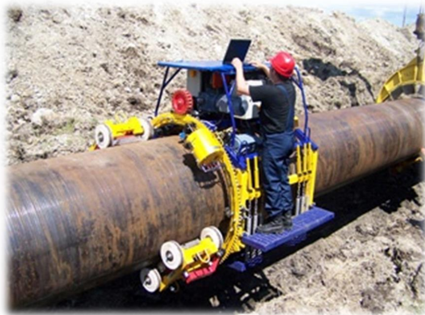
Рисунок 17 – Очищенная поверхность трубы
