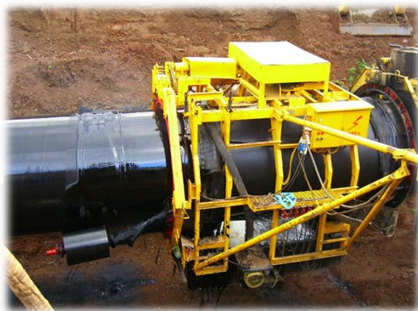
Рисунок 18 – Нанесение нового изоляционного покрытия
