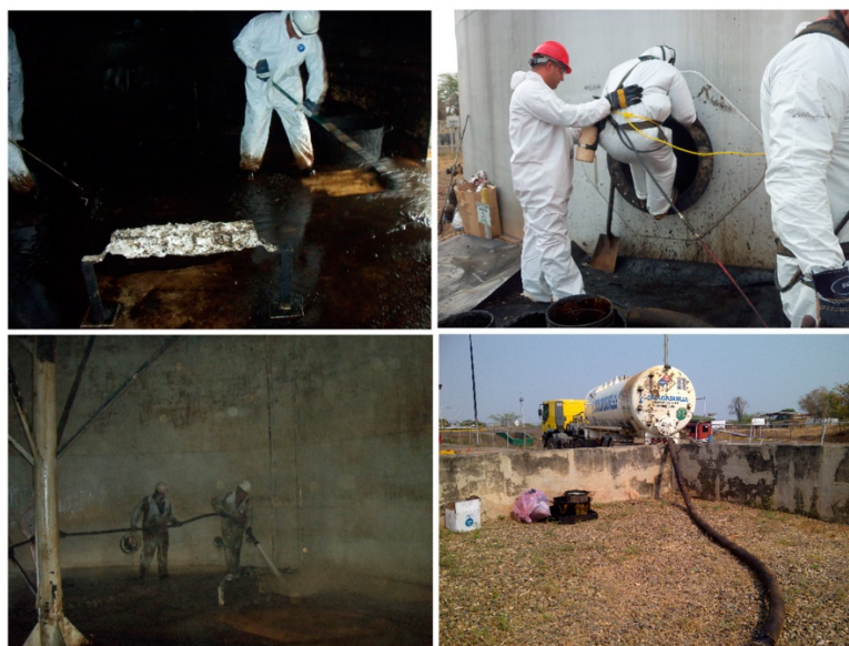
Рисунок 2.4 – Ручной метод очистки резервуара
