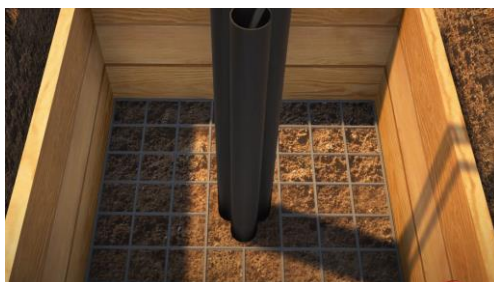
Рисунок 60. Опалубка и армирующая сетка
