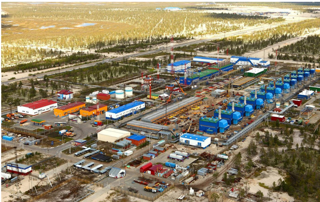
Рисунок 1 – Дожимная компрессорная станция Вынгаяхинского газового промысла
