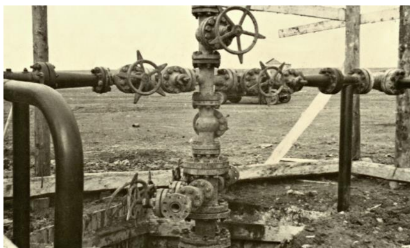
Рисунок 3 – Газовая фонтанная арматура нового образца 1947 года на месторождении Тепловское [1]
