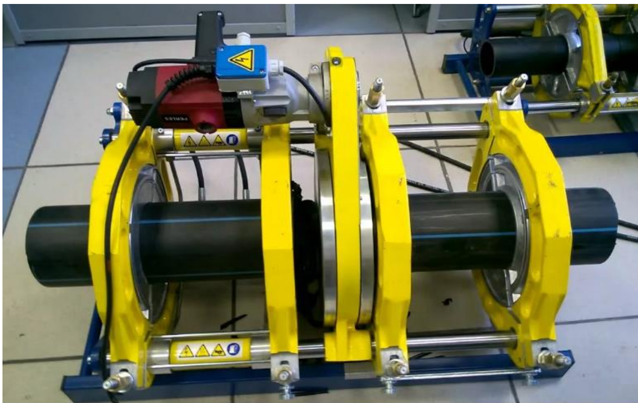
Рисунок 6 – Установка торцевателя между свариваемыми торцами труб [39]
