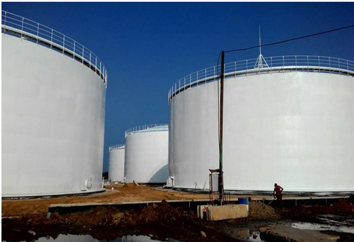
Рисунок 1 - Вертикальные стальные резервуары РВС
