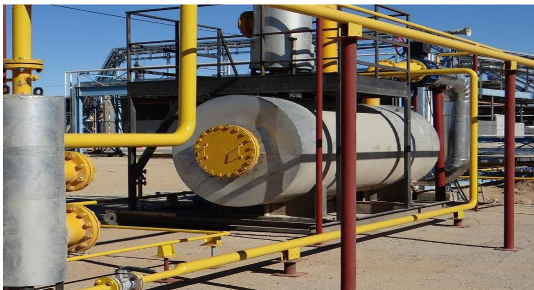
Рисунок 2.2 – Сепараторы газовые СГ
