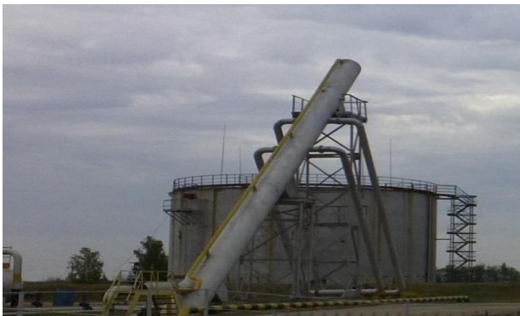
Рисунок 2.4 – Установка трубная сепарационная трубная наклонная УСТН
