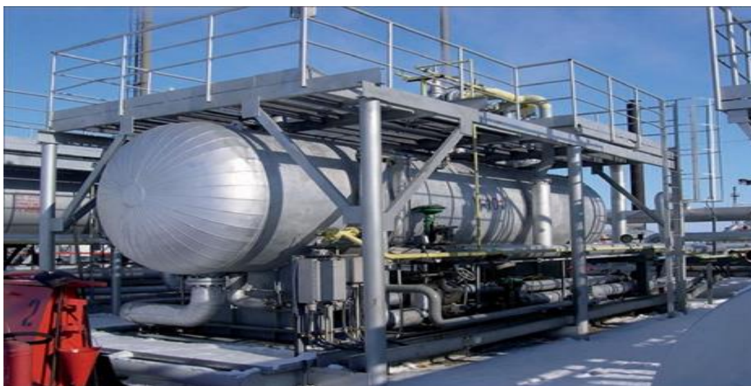
Рисунок 1.6 – Отстойник непрерывного действия
