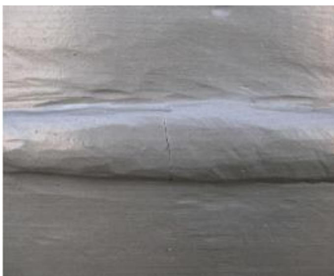
Рисунок 22 – Трещина образованная поперек сварного шва
