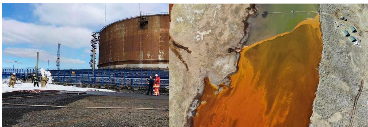
Рисунок 12 – Последствия аварии резервуара в г. Норильск ТЭЦ-3, 2020г.
