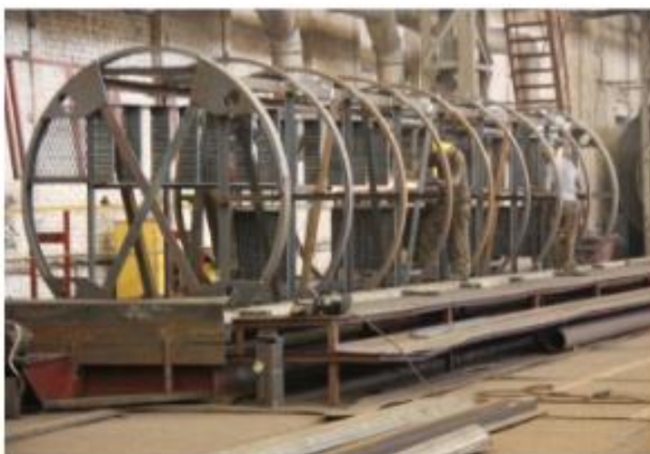
Рисунок 6 – Общий вид каркаса бедующего рулона
