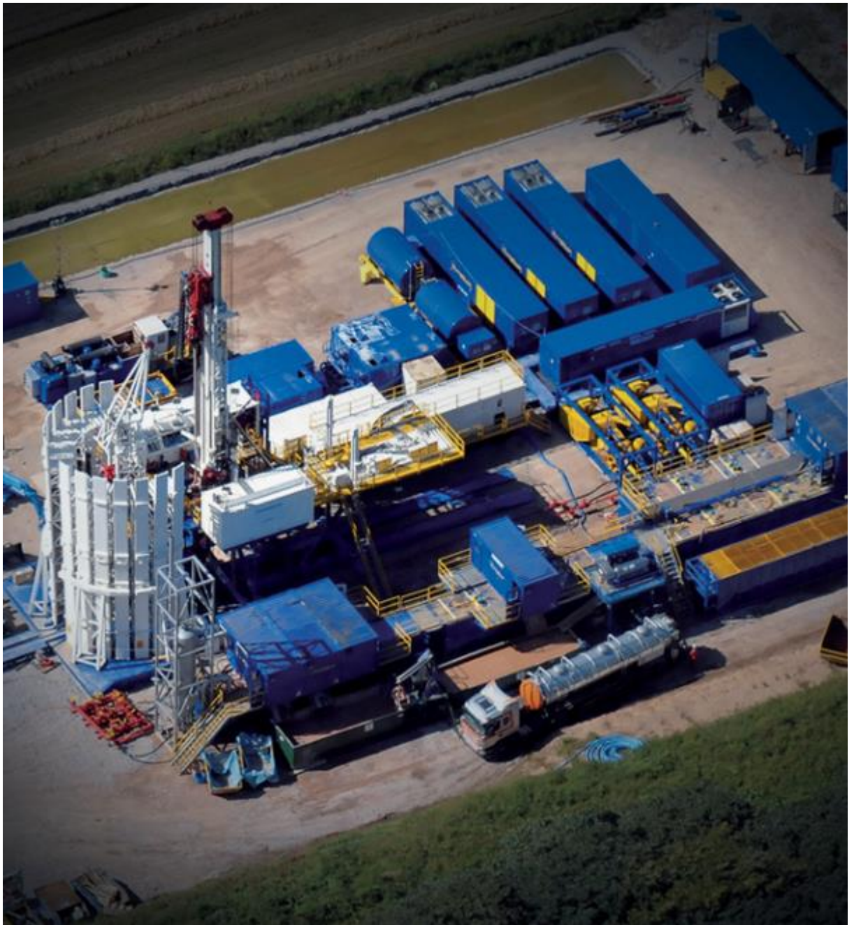
Рисунок 27 – Буровая установка Drillmes NN
